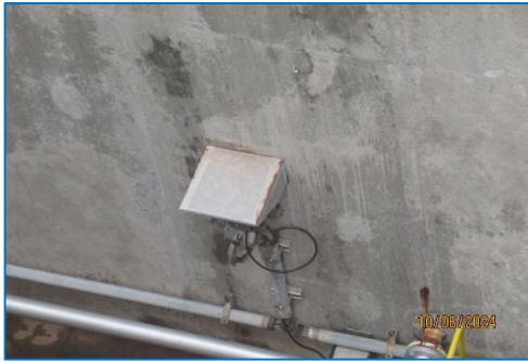
ภาพถ่ายที่ 2.2-23 Gas Detector ที่ถังเก็บ Acetone
