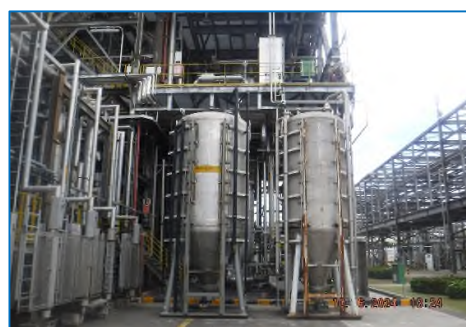
ภาพถ่ายที่ 2.2-6 ระบบดูดซับด้วยถ่านกัมมันต์ ของส่วนผลิต BPA
