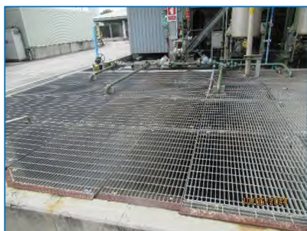
ภาพถ่ายที่ 2.2-11 Process Wastewater Sump
